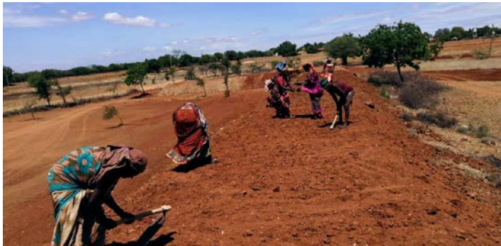
Construction d'un réservoir - GRAMIUM (Fondation Alsthom)
